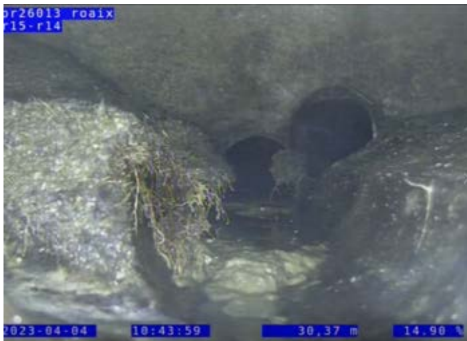
Figure 27 : Complexes racinaires au niveau du regard Impasse Di Caneu
